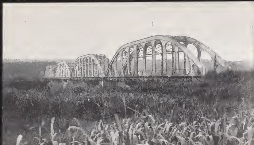
Le grand pont métallique de Bukama.
